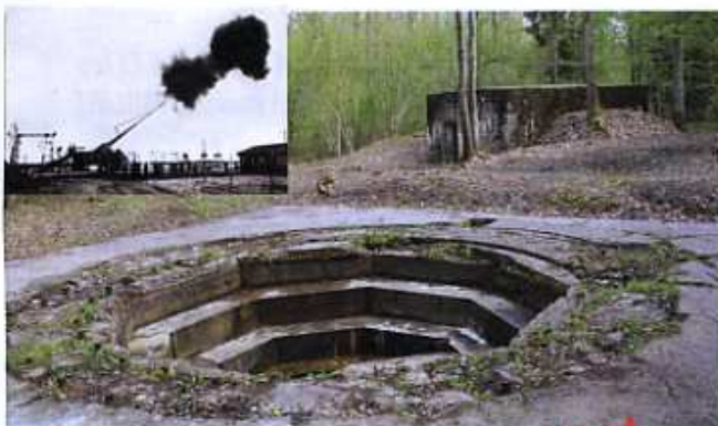
Ce qui reste de la structure aujourd'hui. On voit en fond un des deux bunkers.
